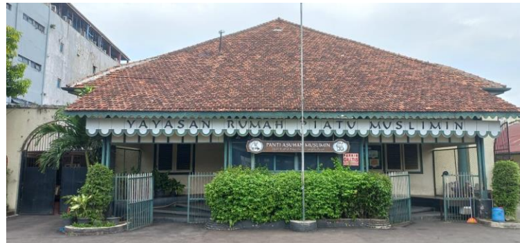
Foto 1. Kondisi Existing Tampak Depan Bangunan Utama
