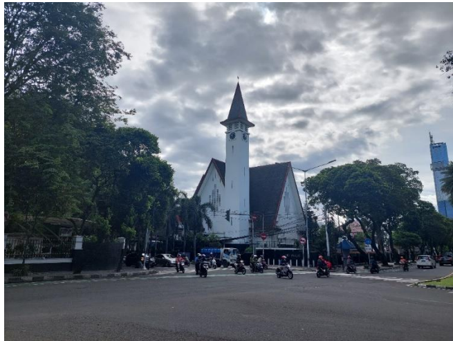
Foto 1. Kondisi Existing Tampak GPIB Paulus dari Taman Patung Diponegoro
