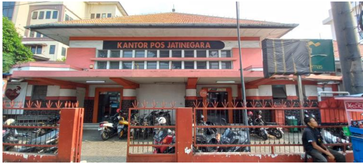
Foto 1. Kondisi existing bangunan utama Kantor Pos Jatinegara
